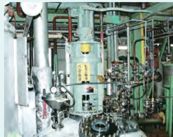
メカニカルシールを加圧するプレッシャーユニットと攪拌機を導入することになり、先に立会い検査で運転を行うことができたので、安心して、設置～実稼働することができました。
