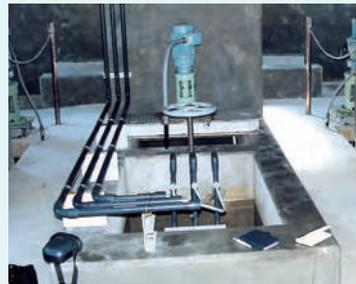
原水の薬品添加工程で、回転範囲が選べる無段変速型の攪拌機を導入しました。変速運転が可能なので、効率が良く、安定しています。
